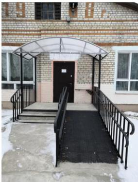
Для обеспечения безопасности и беспрепятственного перемещения детей-инвалидов и детей с ОВЗ вход в здание оборудован пандусом из нержавеющей стали с противоскользящим покрытием, с поручнями.
